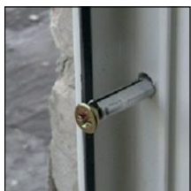
Крепление дверных рам к различным видам оснований
