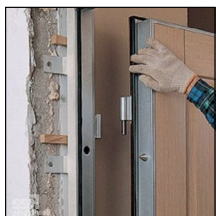
Крепление входных дверей
