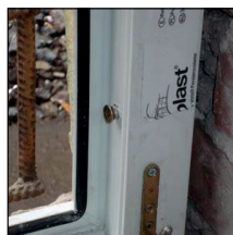
Крепление оконных рам к различным видам оснований
